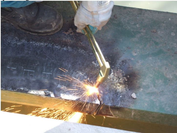
Indul a próbadarab kivágása a 400 mm széles övből (2009. március 2.)
