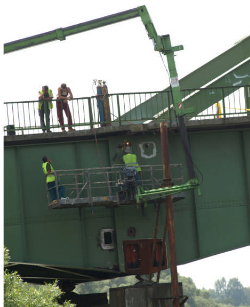
Korróziós vizsgálatok előkészítése
