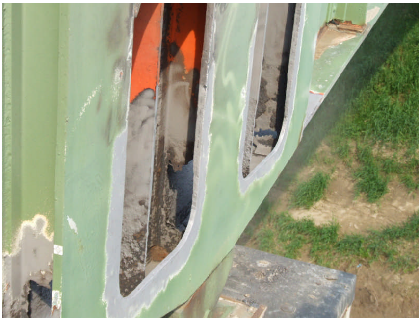
Korróziós vizsgálat kivágott ablakai
