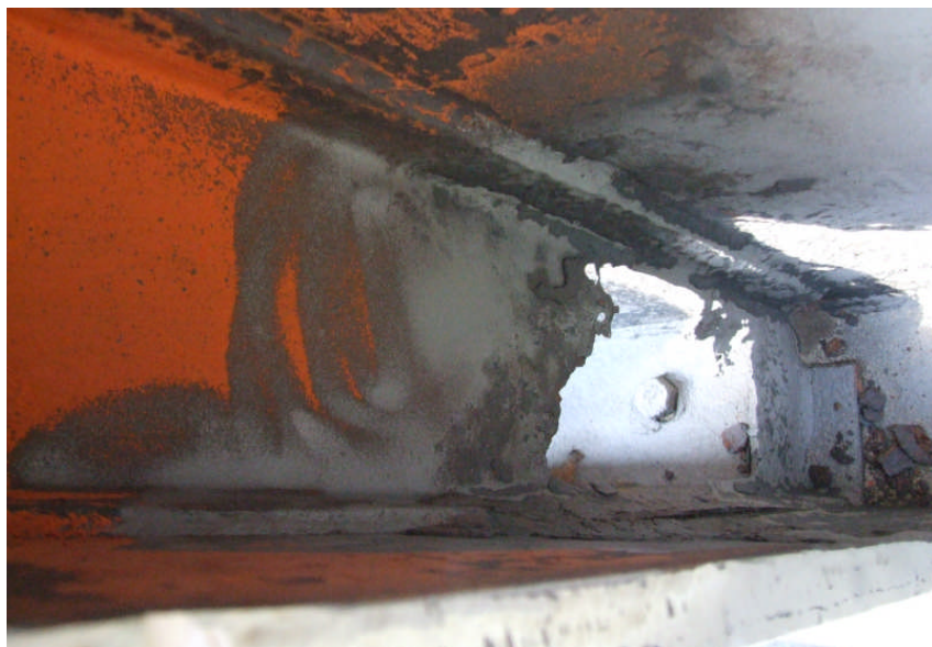
Elfogyott szelvények a saru fölötti erőbevezetés helyén
