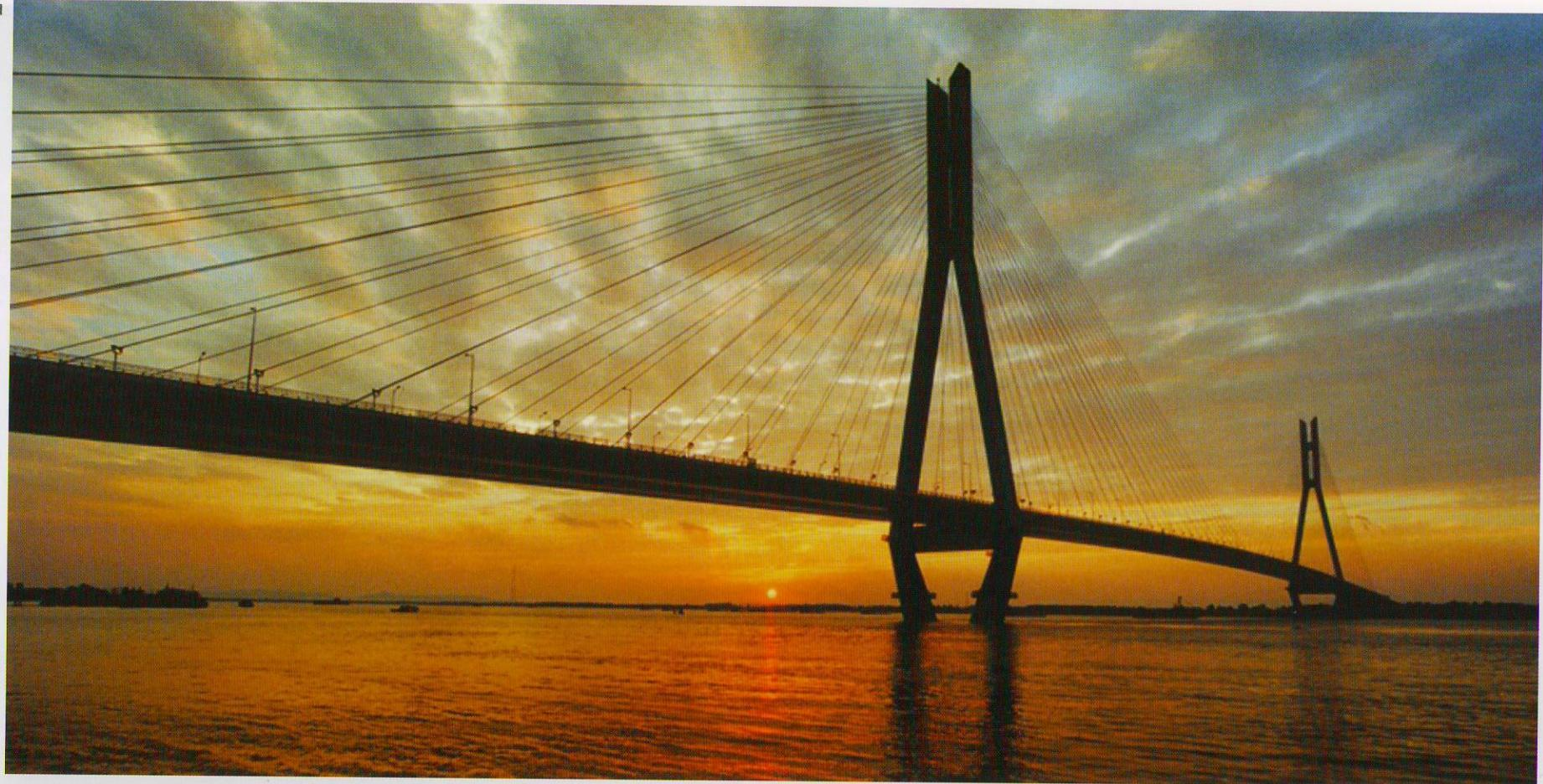
南京长江第二大桥是国家“九五”重点建设项目，位于现南京长江大桥下游11km处。大桥采用跨径 $58.5m+246.5m+628m+246.5m+58.5m$ (总长为1238m)的五跨连续钢箱梁，该跨径目前居同类桥型中国内第一、世界第三。桥面宽32m(不含斜拉索锚固区)。2001年3月建成通车。大桥的建成使我国大跨径斜拉桥设计、施工水平跃居世界领先地位，是我国桥梁建设史上一座新的里程碑。
