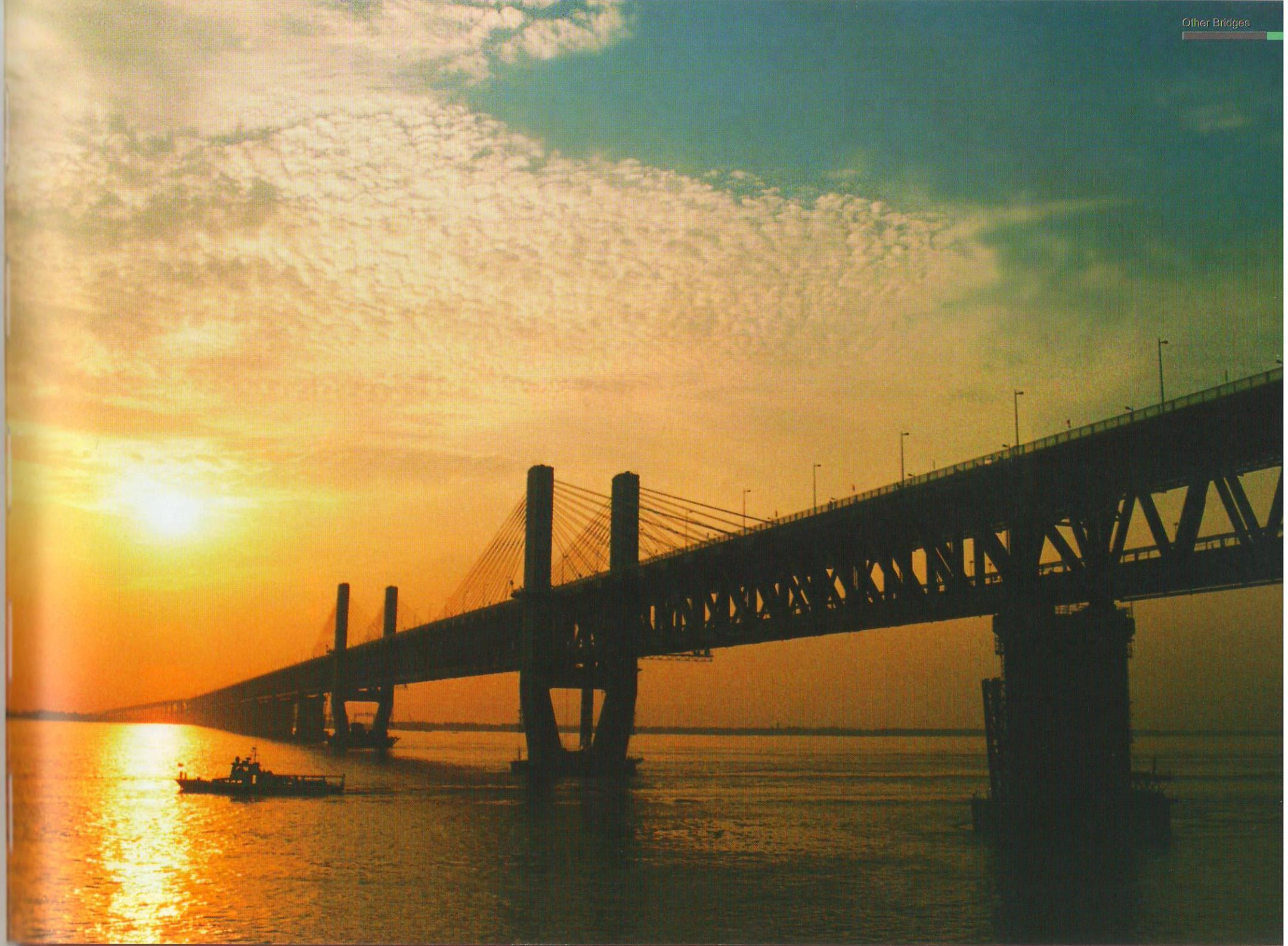
芜湖长江大桥为国家“九五”重点工程，是20世纪末我国在长江上修建的最后一座双层公铁两用桥。铁路桥全长10520.97m，公路桥全长5681.2m，其中公铁两用桥梁全长2668.4m，正桥钢梁长2193.7m，主跨312m，其跨度和建设规模均超过武汉、南京和九江长江大桥。该桥总体布置制约条件较多，上部结构受通航净空、既有铁路编组站和邻近机场飞行净空等严格限制，结合地质、水文等复杂条件，主航道采用180m+312m+180m矮塔斜拉桥，副航道采用四联基本跨度为144m的连续桁梁桥。主跨312m矮塔斜拉桥突破了我国铁路重载桥梁300m跨度大关，板桁组合结构矮塔斜拉桥跨度在相同荷载和类似结构中居世界第一。
