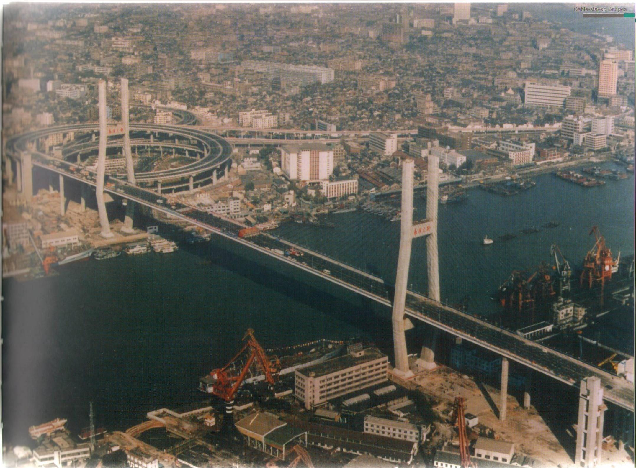
南浦大桥位于上海市南码头，是市区内跨越黄浦江连接浦西老市区与浦东开发区的重要桥梁，是上海市内环线的重要组成部分，也是振兴上海开发浦东的起步工程。该桥全长8346m，主桥长846m，浦东引桥长3746m，浦西引桥长3754m。主跨跨径423m，一跨过江，桥下通航净高46m。桥面宽30.35m，其中六车道车行道宽23.45m，两侧各设2m宽人行道，车行道与斜拉索、人行道间设防撞栏杆。设计荷载为汽-超20级，全重3000kN平板车验算。主桥采用双塔双索面钢与混凝土结合梁斜拉桥。主桥塔高150m，采用折线H形钢筋混凝土塔柱。塔柱每侧索面各22对斜拉索，双索面呈扇形布置，在塔柱中央设置一对垂直索，以代替梁下竖向支承，使主梁在纵向成为漂浮体系。结合梁的平面钢梁格由两个钢工字形主梁、车行道横梁、小纵梁（桥纵轴处）、钢人行道悬臂梁组成。钢主梁的中距为24.55m，梁高2.21m，之间设有纵向间距4.5m的工字形钢横梁。边跨设置辅助墩，主桥两端及边墩处设置640mm组合式大位移伸缩缝。大桥设有4部垂直电梯，供游人上桥游览观光。
