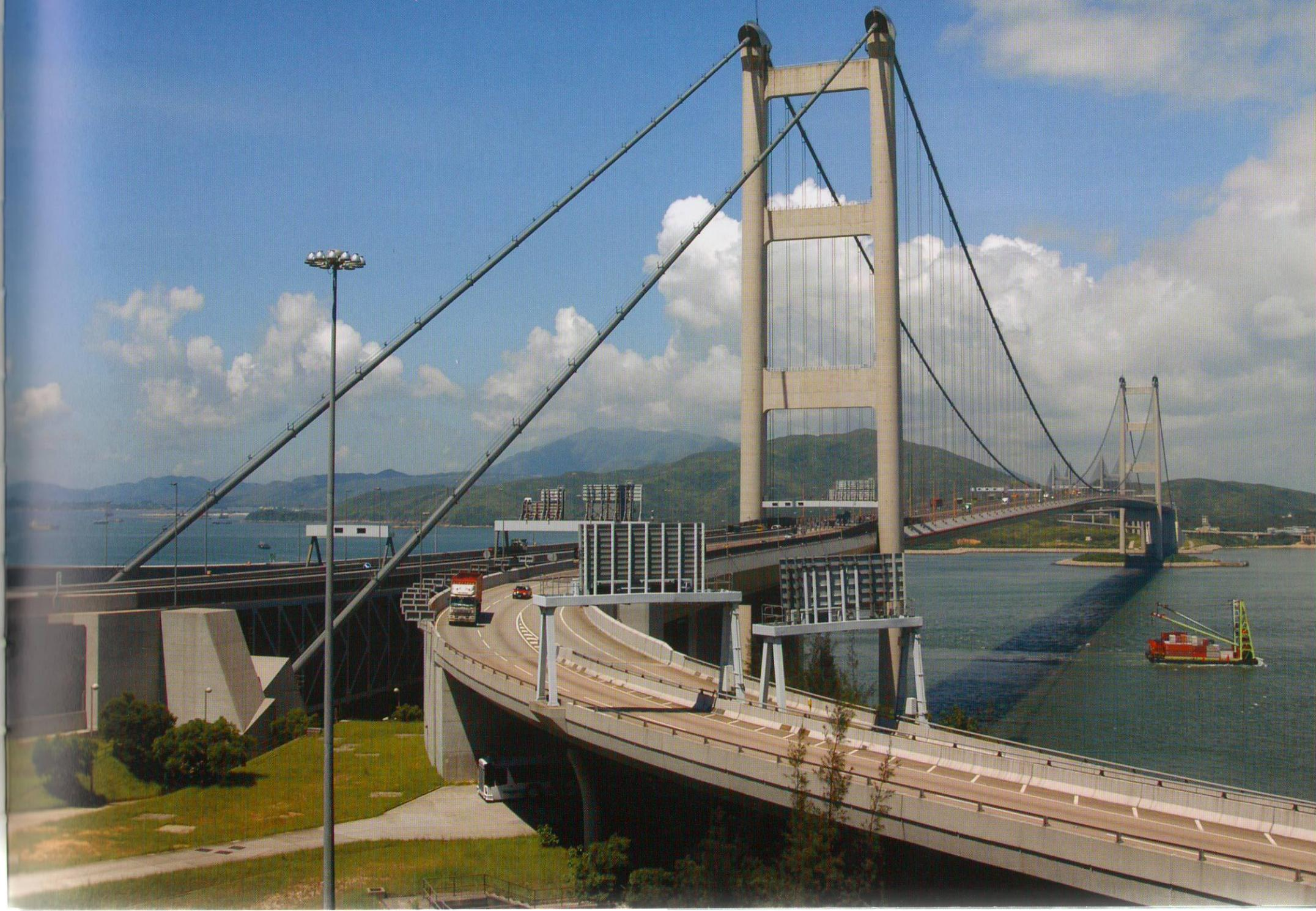
青马大桥横跨青衣与马湾之间的海峡，连接香港大屿山国际机场与市区，是为国际机场而建的十大核心工程之一。桥梁全长2160m，主跨1377m，较长的边跨（长359m）为悬吊结构，较短的边跨（长300m）为非悬吊结构，主缆直径1100mm，建成时为世界最大跨度的公铁两用桥。加劲梁为钢桁与钢箱梁混合结构，横截面尺寸为 $41.0\text{m} \times 7.3\text{m}$ ，建成时为世界最宽的悬索桥。上层桥面设有6条公路行车道，下层钢箱梁内通行铁路交通并设有两条台风时的应急车道，容许时速达135km的列车安全地通过。由于航空高度界限的限制，桥塔的高度为206m，桥下通航净空为79m。大桥锚碇是两个大型的混凝土结构，青衣侧锚碇约重200000t，马湾侧锚碇约重250000t。主缆由直径5.38mm的镀锌高强钢丝组成，采用空中纺缆法架设。吊索由 $2 \phi 76\text{mm}$ 钢丝绳用特殊索箍固定在主缆上，吊索间距18m。主梁共分94个标准单元，每个单元长18m，宽41m、高7.6m。
