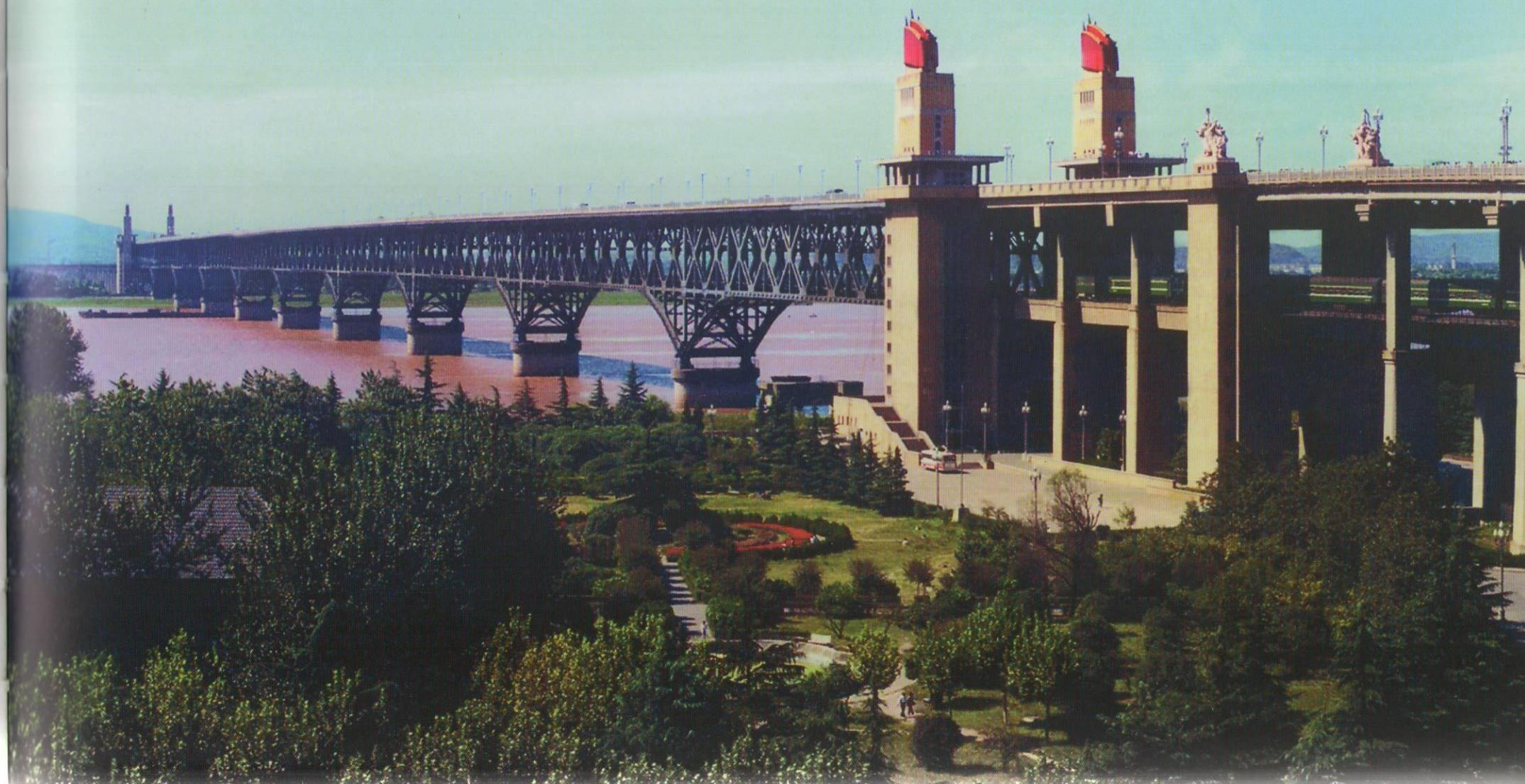
南京长江大桥是连接南北交通干线津浦铁路与沪宁铁路的重要工程，是当时我国跨度最大的公铁两用桥。桥梁铁路部分全长6772m，公路部分全长4588m，其中江面正桥1576m。正桥为10孔公路铁路双层钢连续桁梁桥。浦口岸第一孔为跨径128m的简支钢桁梁，其余9孔为三联三等跨160m的连续钢桁梁，主桁中心距14m，节间长度8m，在跨中处桁高16m，在支点处桁高30m。上层为四车道公路桥，车行道宽15m，两侧人行道各宽2.25m；下层为双线铁路桥。桥下通航净高24m，该工程荣获1985年国家科技进步特等奖。
