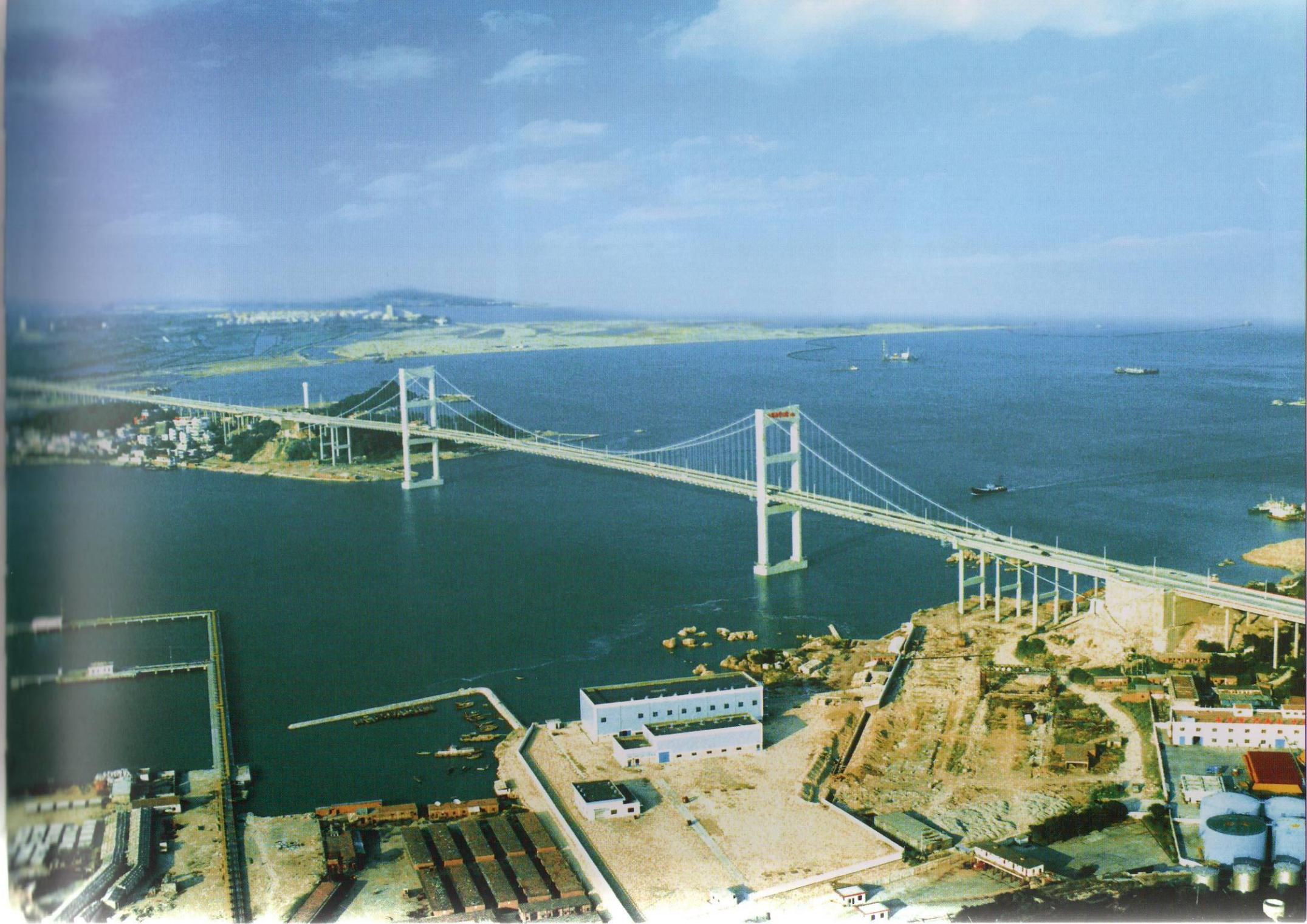
汕头海湾大桥位于汕头市东郊汕头海港的出入口处，是国家规划建设的“两纵两横三条路段”公路主骨架中的同（江）三（亚）线上连接深汕、汕汾两段高速公路的重点工程。大桥的建设对密切港、澳与深、珠、汕、厦四个经济特区的联系起到了“桥梁”纽带作用。大桥全长2629m，主跨452m，是我国第一座大跨度现代悬索桥，也是目前世界上最大跨度的预应力混凝土主梁悬索桥。桥面净宽23.8m，桥下通航净高46m，主塔高95.1m，钢筋混凝土结构，南、北锚碇均为重力式锚。主缆垂跨比为1/10，采用PWS法编制。吊索采用镀锌钢丝捻制而成，吊索锚头采用冷铸锚，吊索间距6m。主梁为菱形预应力混凝土箱梁，中间梁高2.2m，全宽24.72m，标准节段长5.7m。主梁采用分节段预制、拼接、对号存放、现场吊装的方式进行施工。节段间用湿接头连接。
