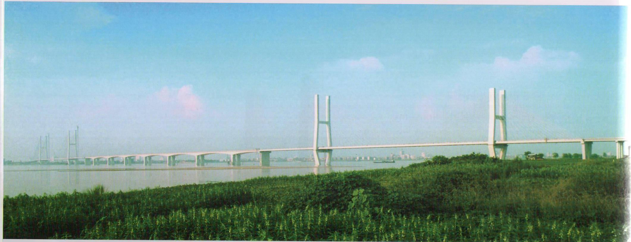
荆州长江大桥是交通部和湖北省“九五”重点建设工程。桥梁全长为4398m，主桥由北汊通航孔桥、三八洲桥、南汊通航孔桥组成。该桥三个主桥中，北汊通航孔桥采用200m+500m+200m预应力混凝土肋板式斜拉桥，三八洲桥采用100m+6×150m+100m连续箱梁桥，南汊通航孔桥采用160m+300m+97m姊妹塔预应力混凝土斜拉桥。荆州长江大桥主跨500m的预应力混凝土斜拉桥是世界上首座跨度达500m的肋板式断面预应力混凝土斜拉桥，建设规模和技术难度居同类型桥梁世界之最。
