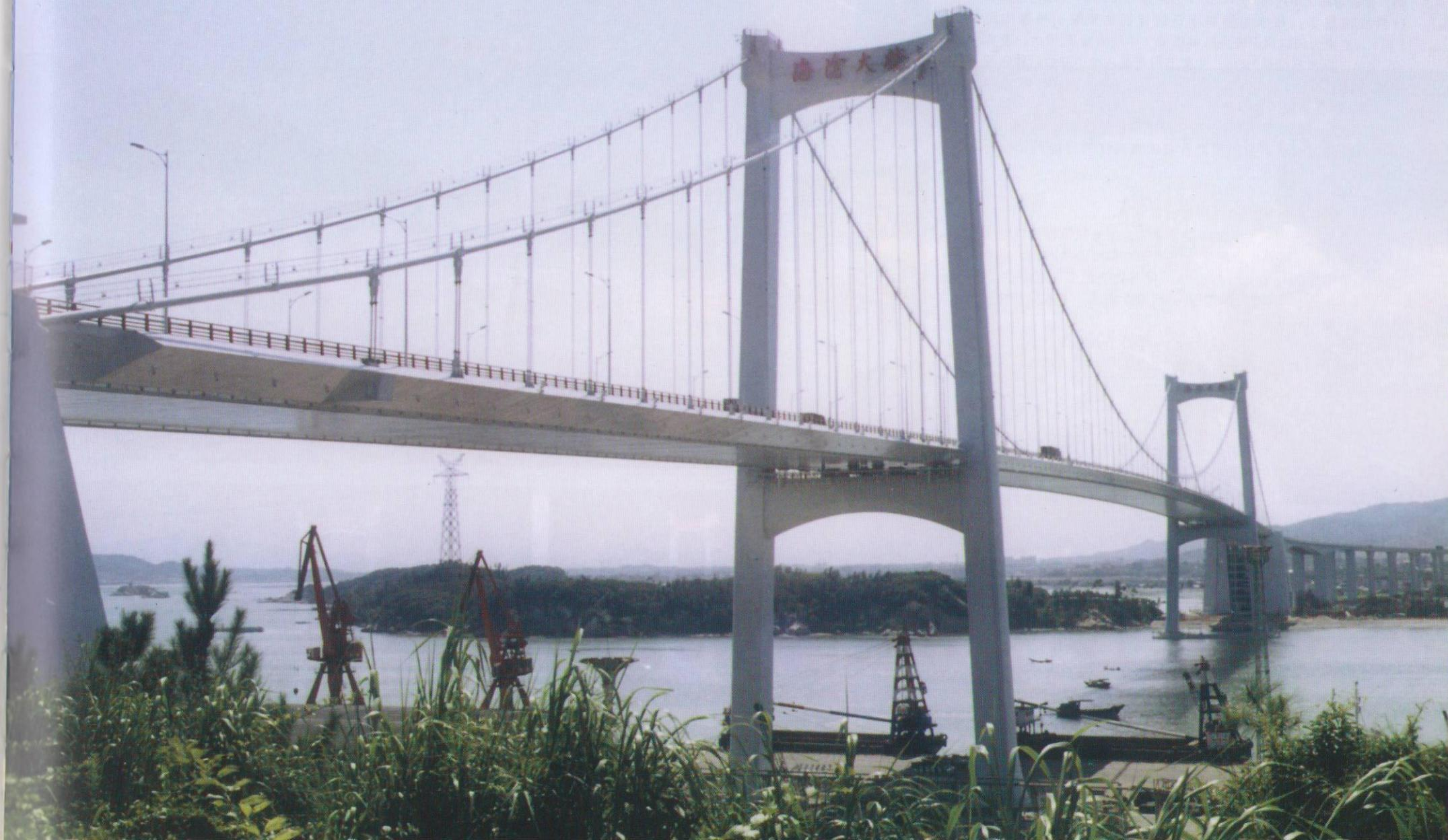
厦门海沧大桥位于厦门市西海域，连接厦门东渡码头和大陆海沧开发区，是大陆与厦门本岛第二条重要的进出岛通道。大桥采用结构新颖美观的三跨连续全漂浮钢箱梁悬索桥桥型，按双向六车道设计，桥梁宽度32m，计算行车速度为80km/h，桥下通航净高55.0m，主塔高128.025m，由钢筋混凝土塔柱和两道横系梁组成。采用重力式锚碇，基础为浅埋箱形扩大基础。主缆垂跨比中跨为1/10.5，边跨为1/29.01，采用预制平行索股法施工。吊索为预制平行镀锌钢丝束股，吊索间距12m。主梁为闭口扁平流线形钢箱梁，中间梁高3.0m，全宽36.6m，标准节段长12m。主梁节段吊装从跨中开始对称向两侧逐段施工。
