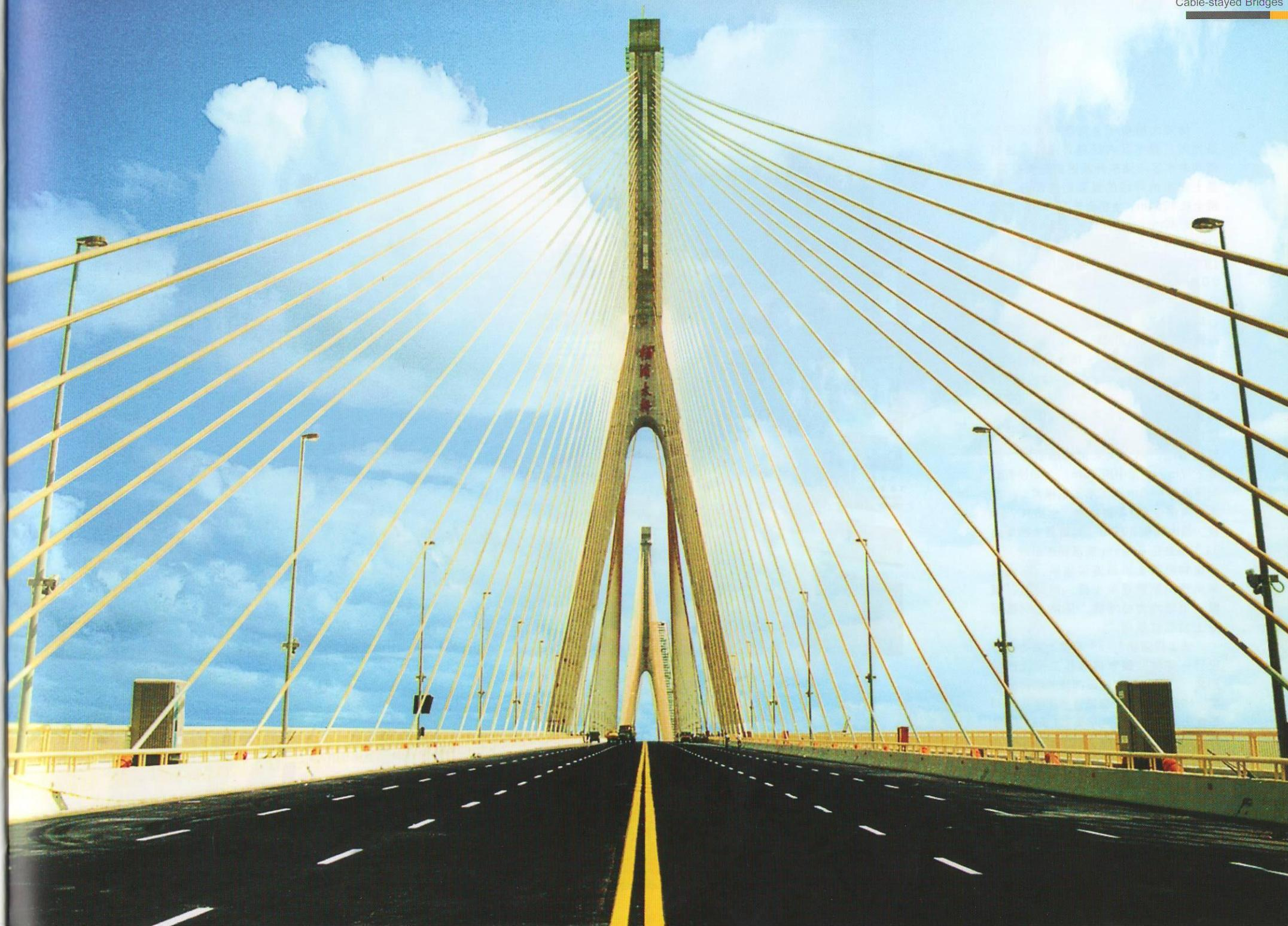
杨浦大桥位于上海市杨浦区宁国路地区，是市区内跨越黄浦江、连接浦西老市区与浦东开发区的重要桥梁，是上海市内环线的重要组成部分。该桥全长8354m，主桥全长1172m，跨径组合为40m（过渡孔）+（99m+144m）（边跨）+602m（主跨）+（144m+99m）（边跨）+（44m）（过渡孔）。主跨跨径602m在建成时为同类桥型世界之最。桥下净高50m，桥面总宽30.35m，车行道约2.3m，两侧人行道各2m，设计荷载为汽-20（局部超-20）、挂-120，设计车速60km/h。主桥为双塔空间双索面钢—混凝土结合梁斜拉桥结构，塔墩固结，纵向为悬浮体系，并在横向设置限位和抗震装置。钢筋混凝土塔柱高200m，塔型呈钻石状，采用钢管桩基础。钢主梁采用箱形断面，梁高2.7m，主梁中距25m，之间设有纵向间距为4.5m的工字形钢横梁。每座索塔两侧各有32对拉索，全桥共256根。最大索长330m，拉索最大断面由313根直径 $\phi$ 7mm高强钢丝组成。上部结构为简支桥面连续体系，车道板采用预制钢筋混凝土板。辅助墩、锚墩、边墩均为柱式墩，采用了钢筋混凝土预制桩基础。
