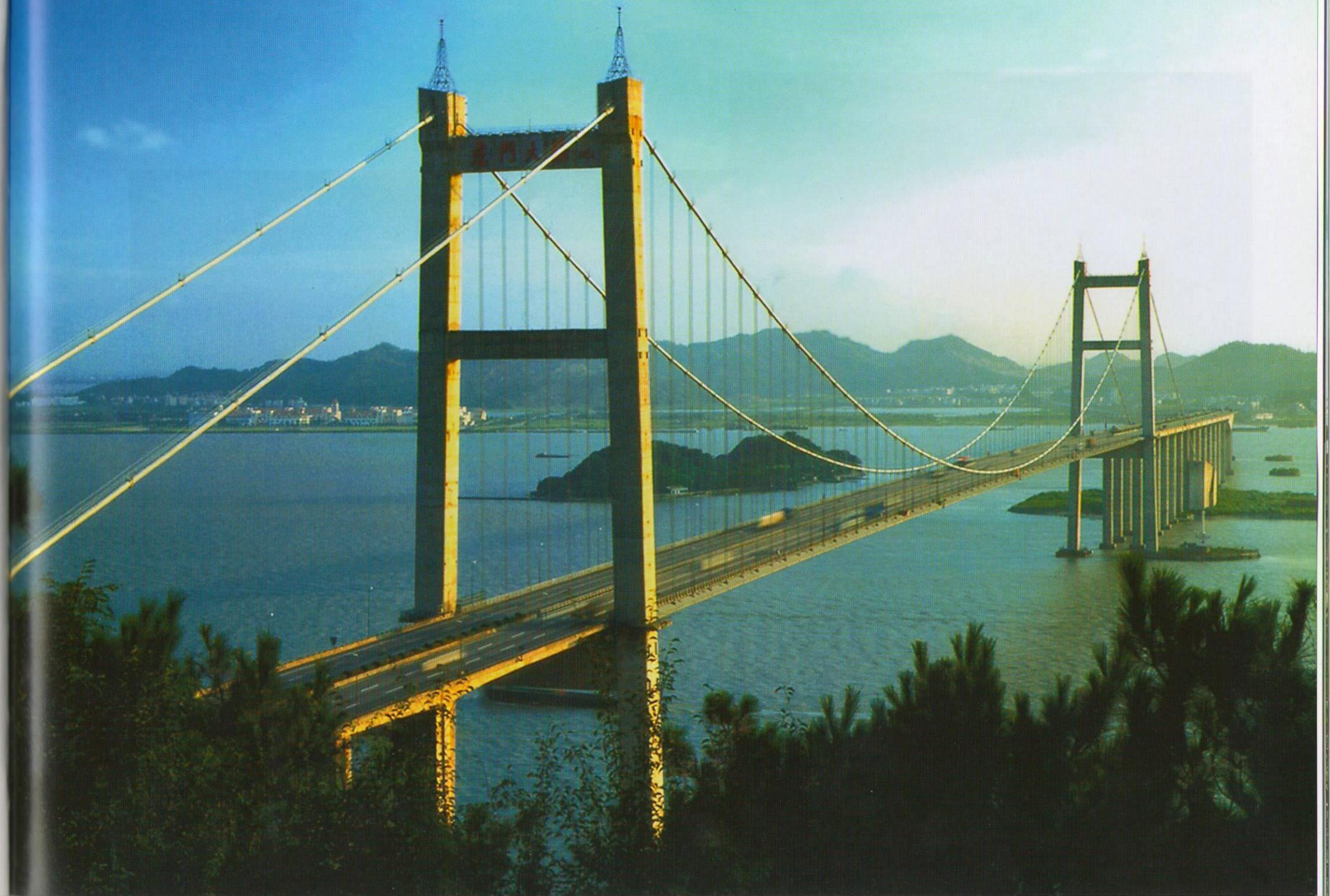
虎门大桥工程位于广东省珠江三角洲中部，是广州—深圳—珠海高速公路跨越珠江的一座特大型公路桥梁。大桥全长15.76km，主桥长4.606km。主航道桥为跨径888.0m加劲钢箱梁悬索桥，是我国当时已建成的规模最大的高速公路悬索桥。辅航道桥为跨径 $150+270+150=570m$ 的预应力混凝土连续刚构桥，建成时居世界同类桥梁之首。主辅航道桥通航净高分别为60m和40m。桥面为双向六车道，宽30m。工程于1992年10月28日动工兴建，1997年6月9日竣工。
