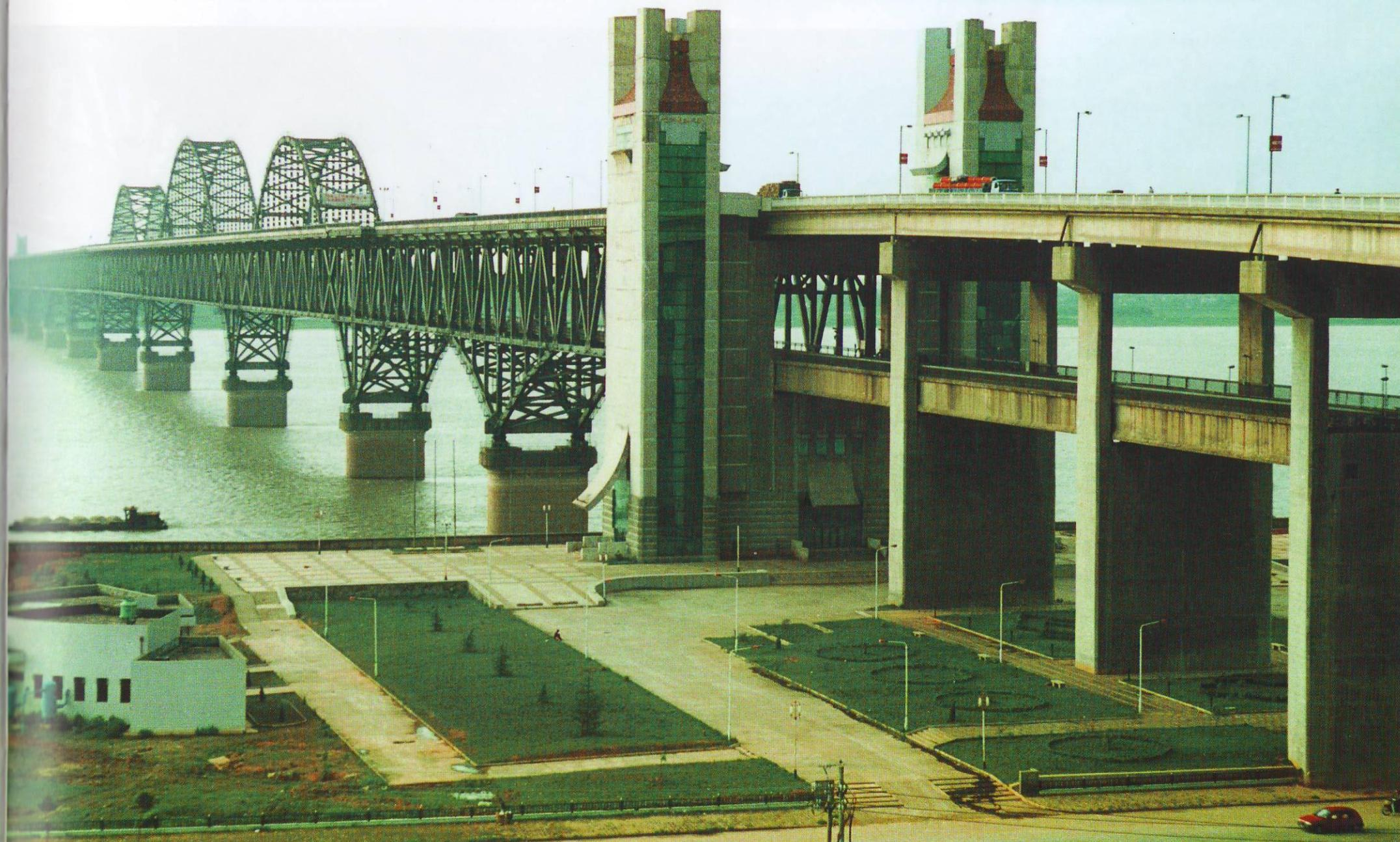
九江长江大桥是我国铁路南北通道京九线和公路干线 105 国道上的重要桥梁。该桥由正桥和南北两岸公路、铁路引桥组成。全桥铁路部分长 7675.09m，公路部分长 4460.122m。正桥共 11 孔，自北向南为：两联  $3 \times 162\text{m}$  连续钢桁梁、一联  $180\text{m} + 216\text{m} + 180\text{m}$  柔性拱加劲的钢桁梁和一联  $2 \times 162\text{m}$  连续钢桁梁。桁宽 12.5m，桁高 16m，最大加劲弦高 16m，最大加劲弦矢高 3.2m。所有钢梁均为栓焊结构。
