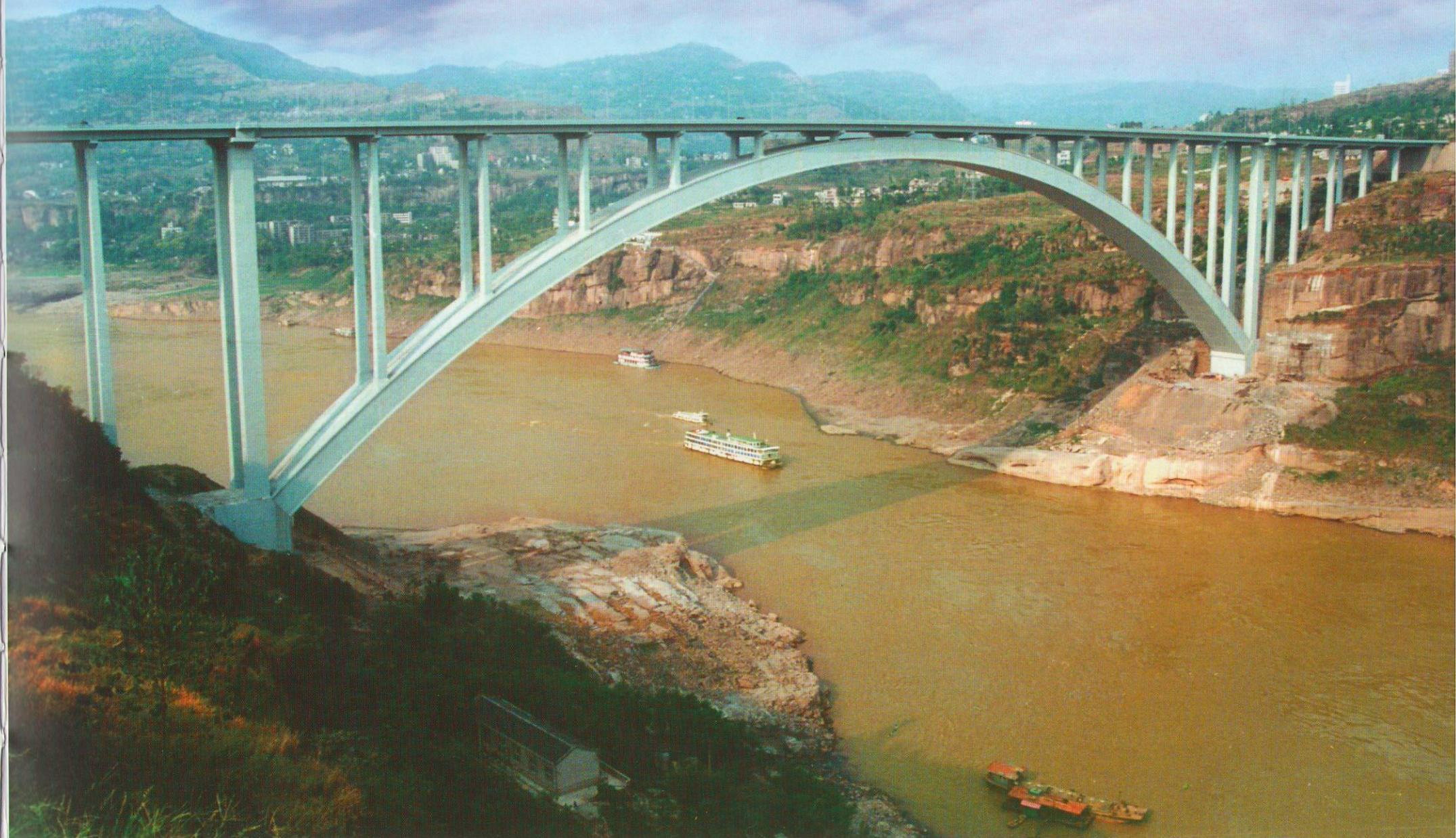
万县长江大桥是国道主干线上上海至成都公路在重庆万州跨越长江的一座特大型公路桥梁。大桥主孔跨径420m，全长856m，桥面全宽24m，桥高147m（枯水位以上）。主拱轴线为悬链线，矢跨比1/5，拱轴系数1.6。拱圈为单箱三室截面，箱高7m、宽16m；拱箱标准段顶、底板各厚0.4m，腹板厚0.3m；拱脚段顶、底板各厚0.8m，腹板厚0.6m。拱上及引桥为同一孔跨贯通布置，共27孔30.668m预应力混凝土T梁，桥面连续。拱圈采用钢管混凝土劲性骨架外包C60级高强混凝土复合结构。其中钢管混凝土劲性骨架先期是施工构架，在拱圈形成后它就成为拱圈内的劲性钢筋。大桥于1994年5月开工、1997年6月竣工，是当时世界上跨径和规模最大的钢筋混凝土拱桥。
