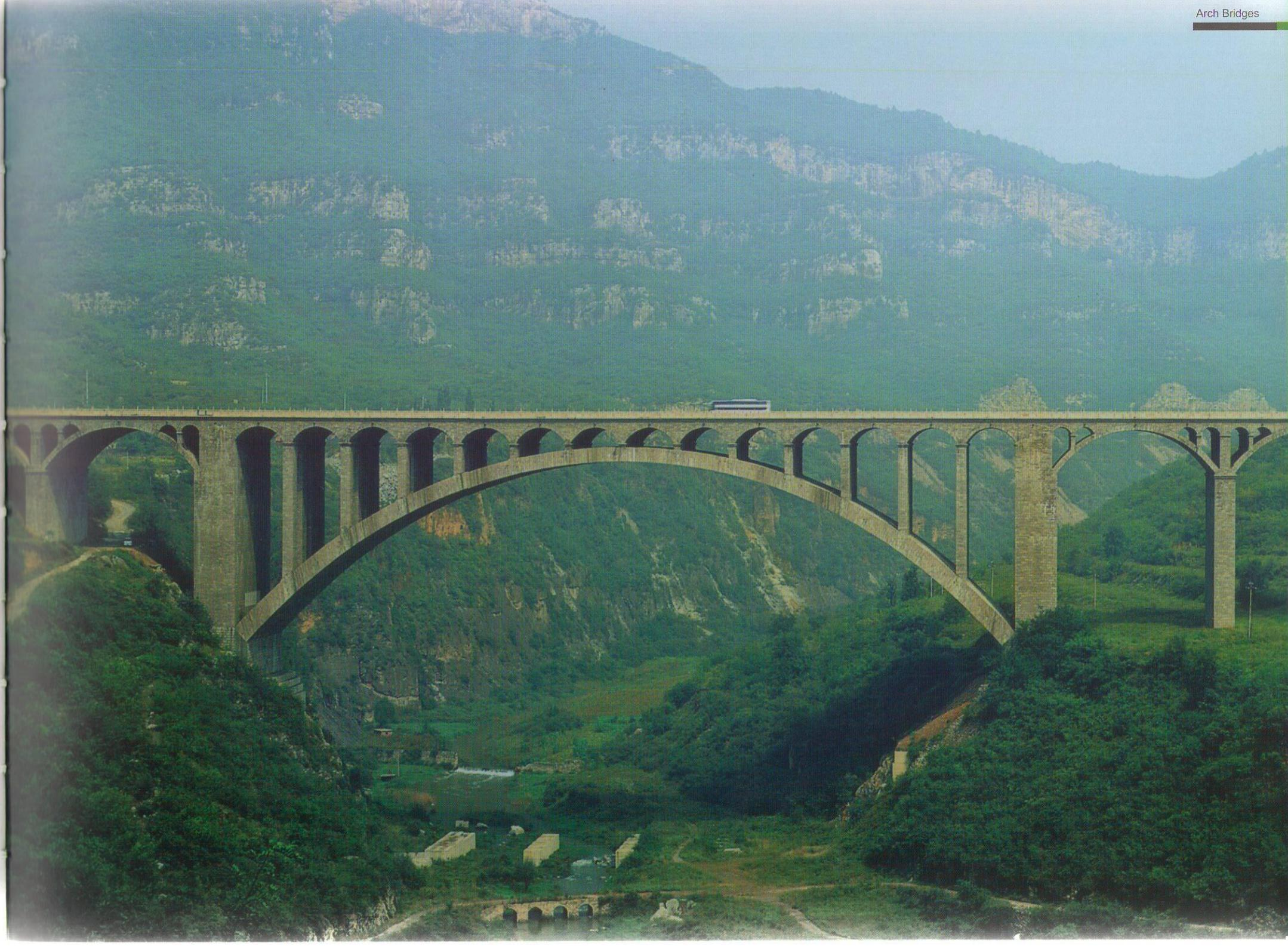
丹河大桥位于山西省晋城市太行山西麓的丹河上，是山西晋城至河南焦作高速公路上的一座特大型桥梁，也是中国第十八座跨径百米以上的石拱桥。桥梁全长413.7m，主跨146m，其跨径组成为：2×30m+146m+5×30m，是目前世界上同类桥型中最大跨径的桥梁。主桥拱上建筑由14孔跨径9.4m、厚度0.6m的腹拱组成。桥面宽24.8m，净矢高32.444m，拱顶和拱脚主拱圈厚度分别为2.5m和3.5m，桥梁高度80.6m。主拱圈采用C40小石子混凝土砌100号大料石；基础采用C30片石混凝土；腹拱填料采用加气混凝土；桥面铺装为钢纤维混凝土；除推力墩与截面较大的腹拱墩采用浆砌片石外，其余均采用C30小石子混凝土砌60号料石。
