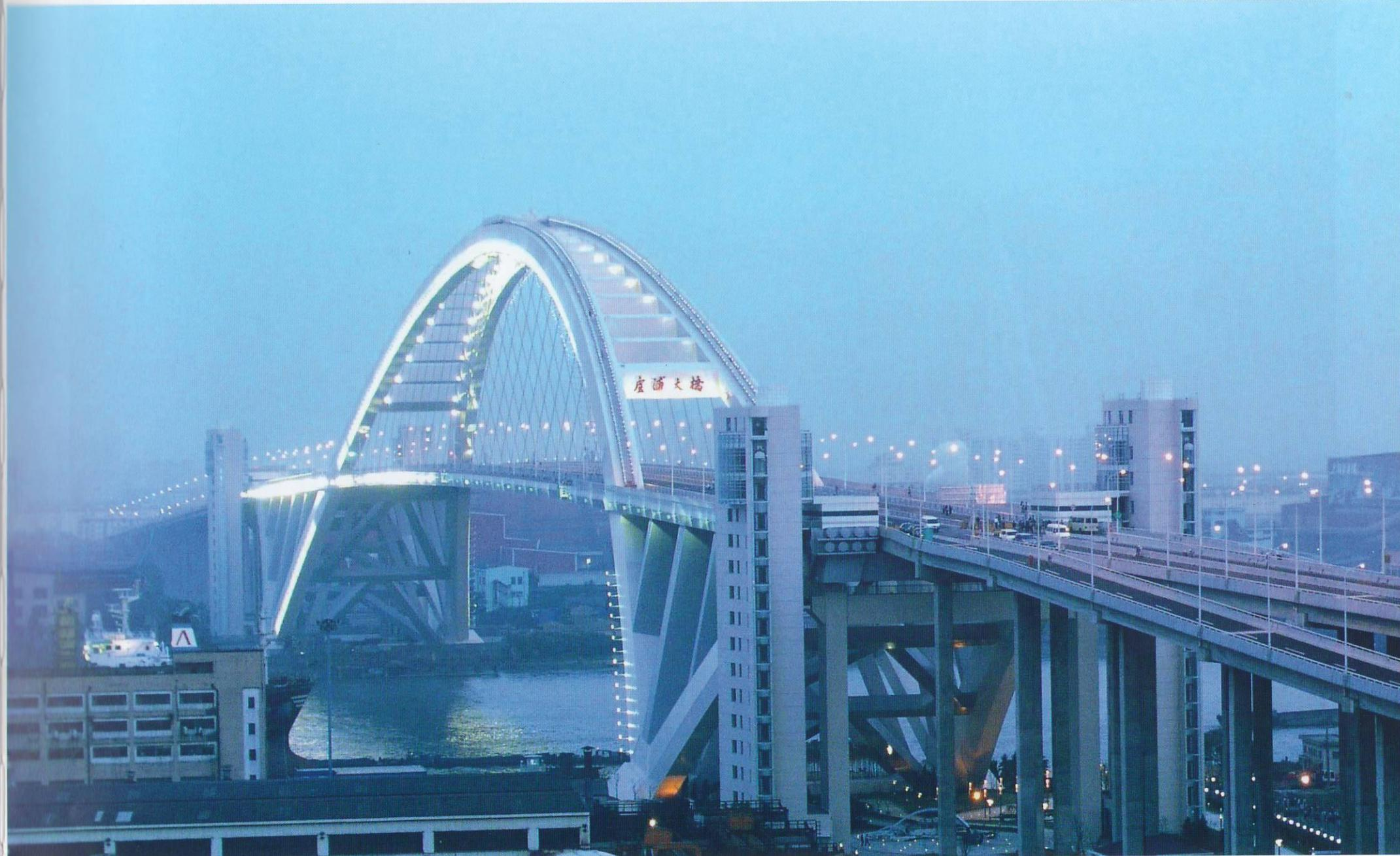
卢浦大桥主桥长750m，主跨跨径550m，居同类桥型世界第一，边跨跨径100m，矢跨比 $f/L = 1/5.5$ ，为全钢结构中承式系杆拱桥。主桥设双向六车道，两边各设2m宽的观景人行道。通航净宽340m，通航净高46m（含2m富余高度）。
