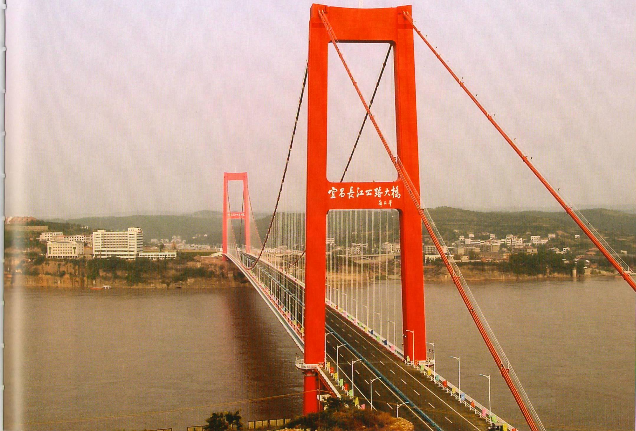
宜昌长江大桥是沪蓉国道主干线在宜昌长江河段跨越长江经湖北省西段进入重庆市的特大型一级公路桥梁，是国家和湖北省“九五”重点建设工程。主桥采用主跨960m单跨双铰钢箱梁悬索桥。宜昌长江大桥是我国完全依靠自身技术力量和建筑材料建成的最大跨径悬索桥。桥面全宽30m，净宽26m，桥下通航净空425mx24m。主塔为门架式，高112.415m(北)、142.227m(南)，由钢筋混凝土箱形截面塔柱和三道横系梁组成。锚碇为深埋重力式锚碇。主缆垂跨比为1/10，采用预制平行索股法(PPWS法)施工。吊索为骑跨式，吊索间距12.06m。主梁为鱼鳍式钢箱梁，中间梁高3.0m，全宽30m，梁高与跨度比为1:320。主梁采用无支架缆载吊机拼装。
