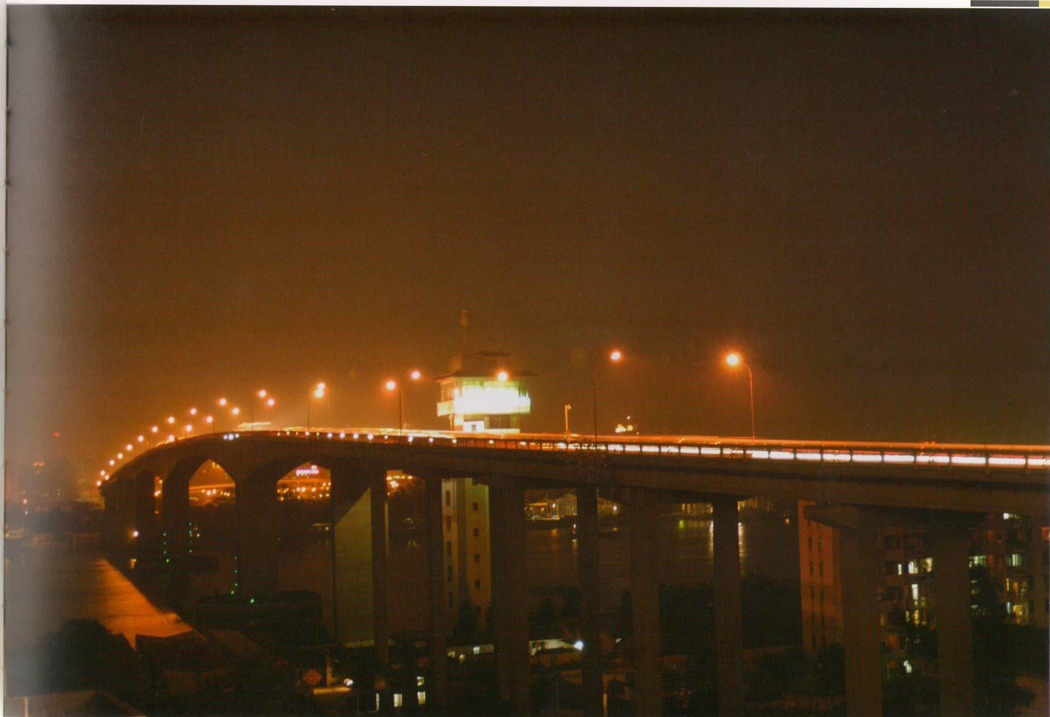
洛溪大桥是跨越广州港出海南航道的一座特大桥，桥梁全长1916.04m，主桥长480m，跨径布置为65m + 125m + 180m + 110m。建成时位列当时同类桥型世界第六、亚洲第一。两岸引桥均为弯桥，引桥全长1436.04m，北引桥平曲线半径1000m，南引桥半径600m，桥面纵坡4%，采用跨径16m的普通钢筋混凝土T梁和跨径30m预应力混凝土T梁。洛溪大桥的建成是我国预应力桥梁建设的里程碑。
