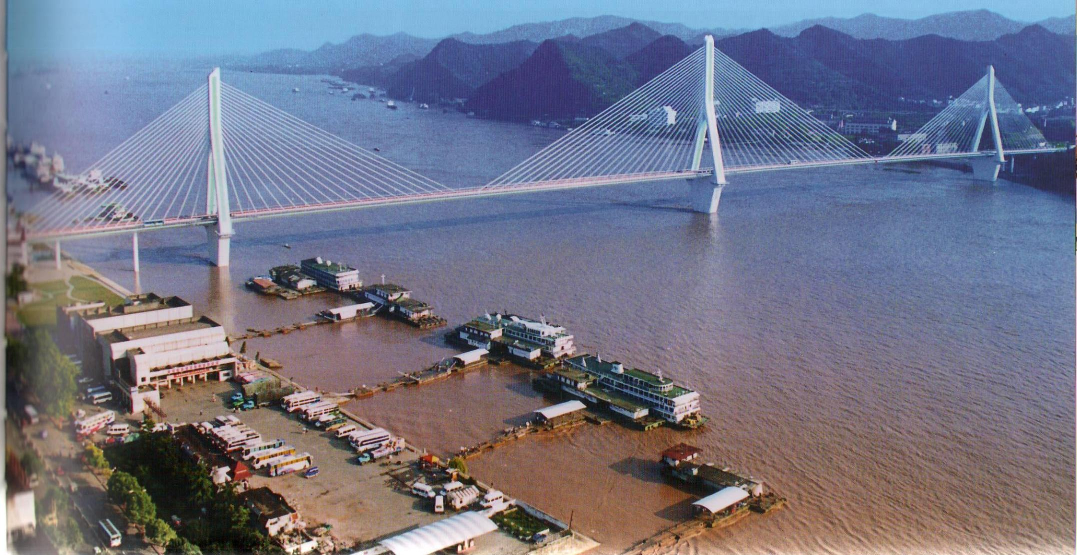
夷陵长江大桥位于湖北省宜昌市，跨越长江，是联系宜昌市南、北两岸的城市桥梁。桥位距葛洲坝水利枢纽大坝下游约7.6km，桥址区江面宽约800m，最大水深约23m。结合桥址区航道具体情况，大胆创新，提出三塔单索面斜拉桥方案，其 $2 \times 348\text{m}$ 的主跨为国内第一，在世界同类型桥梁中亦属前列。桥梁全长3246m，主跨348m，桥面宽23m，桥下通航净高 $\geq 18\text{m}$ 。主塔高126m，边塔高106.5m。主梁采用单箱三室截面，梁高3.0m，顶板宽23.0m，底板宽5.0m。两主跨主梁采用预制悬拼施工。
