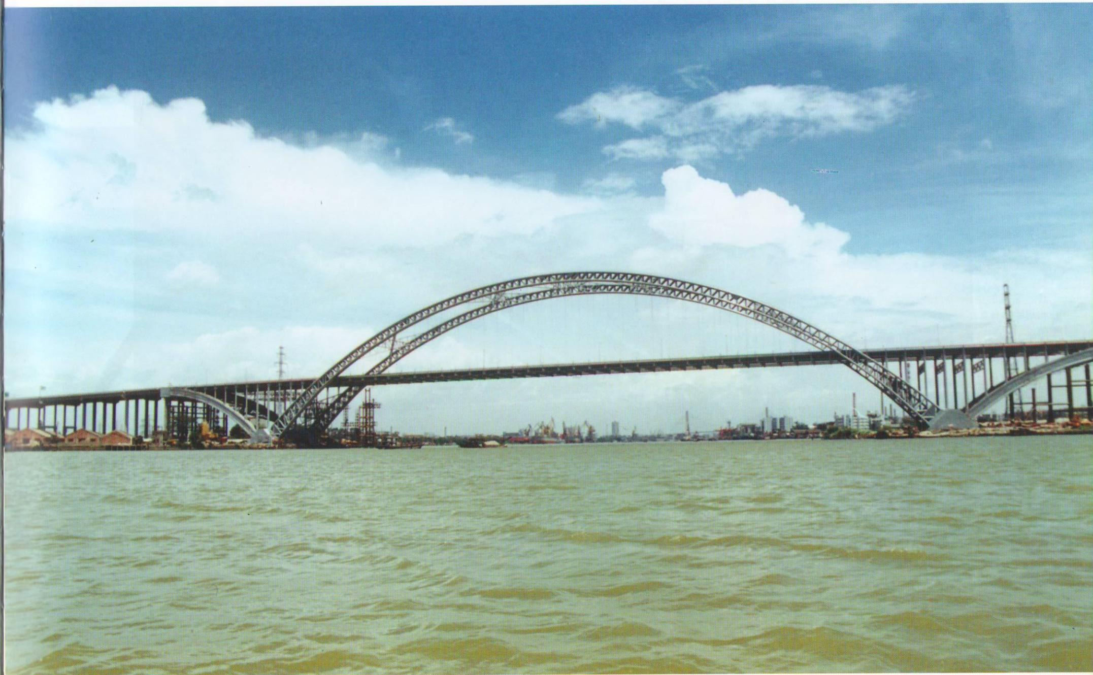
广州丫髻沙大桥是广州市环城高速公路上跨越珠江的三跨连续自锚中承式钢管混凝土系杆桁架拱桥，分跨为 $76\text{m}+360\text{m}+76\text{m}$ ，桥宽 $36.5\text{m}$ 。边跨、主跨拱脚均固结于拱座，边跨设盆式支座，两边跨端部之间设钢绞线系杆，通过边跨半拱平衡主拱水平推力。主拱肋采用悬链线无铰拱，矢高 $76.45\text{m}$ ，矢跨比 $1/4.5$ 。拱肋中心距为 $35.95\text{m}$ ，共设置6组“米”形、两组“K”形风撑。
