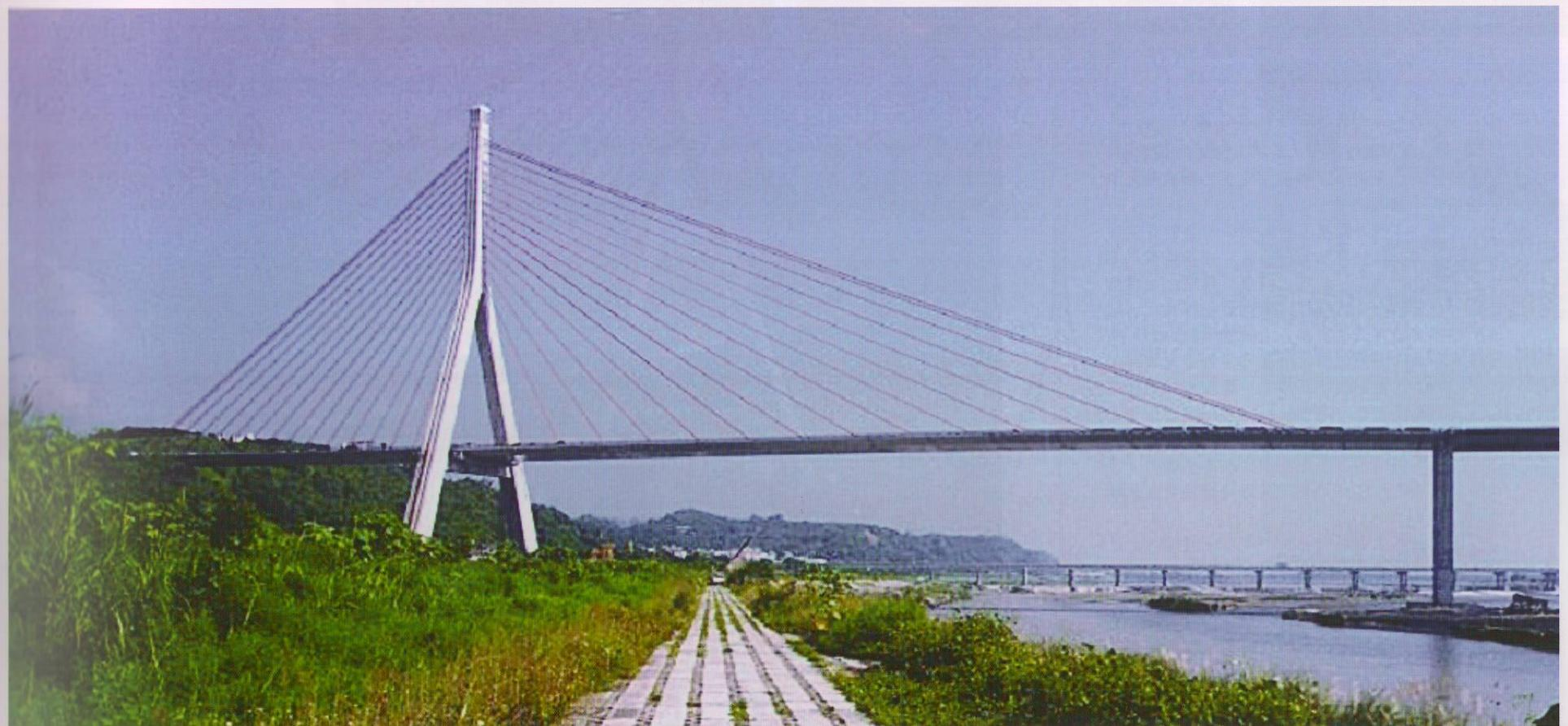
高屏溪桥位于台湾省南部的南二高速公路跨越高屏溪处。该桥的结构形式为独塔中心索面混合梁斜拉桥。斜拉桥全长510m，梁宽34.5m，梁高3.2m，采用独塔非对称布置。全桥长2617m，其中主跨330m，在当今世界上同类桥型中排名第二。采用倒Y形桥塔，拉索均设置于顶柱上，共14对，呈单面辐射状。主跨为钢梁，边跨为预力混凝土梁。采用节段拼装法施工，所有断面的联结采用全焊接方式。
