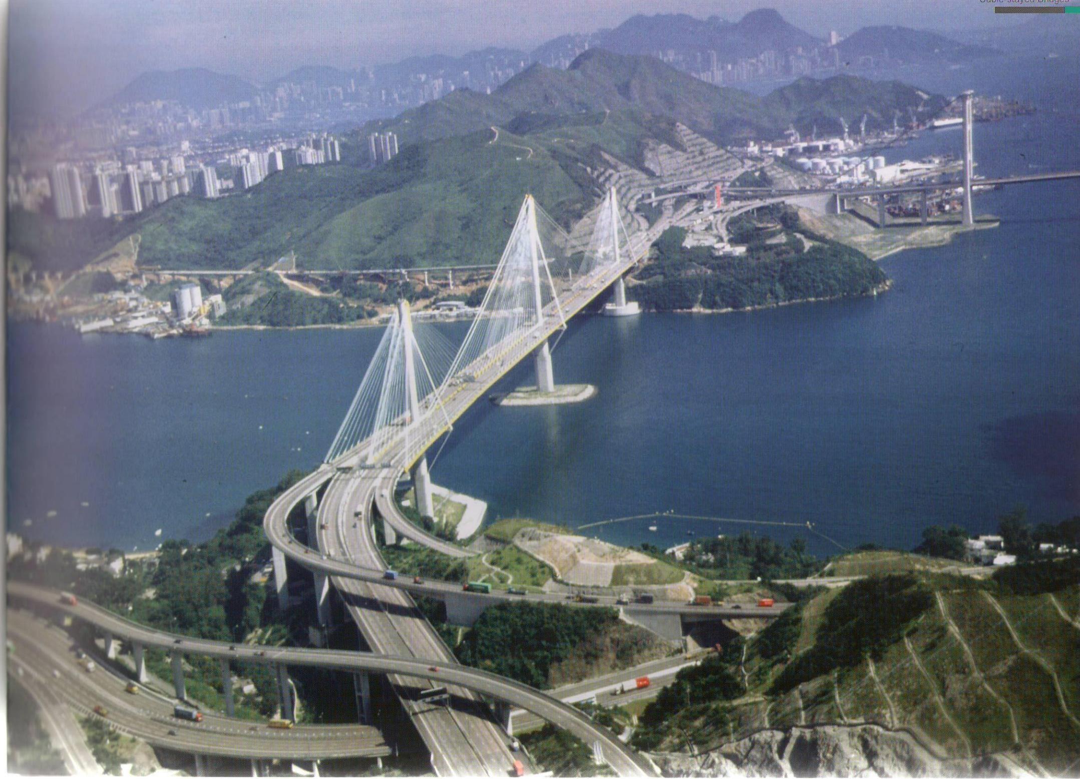
汀九桥及其高架引道横跨蓝巴勒海峡，贯穿香港岛、九龙市区新界西北部。该桥为三塔独柱式斜拉桥，采用全漂浮体系，主跨为448m及475m，而两边跨各为127m，双向六车道，位居世界上同类型斜拉桥之首。结构最大特点为采用三座单柱桥塔，桥面分别建于三座桥塔两侧，中间约有5.5m空隙，使桥梁外观更为纤巧，并可增加桥身在强风吹袭时之稳定性。斜拉索布置为四个索面，线条美观。中央主塔位于海峡中央，由一人工岛保护。而中央主塔之纵向刚度，巧妙地运用纵向稳定索，由主塔顶分别连接两边塔桥面处，长达465m，是当今世界最长之拉索。而桥塔也利用横向稳定索增强横向刚度，以抵抗台风时极高风速。
