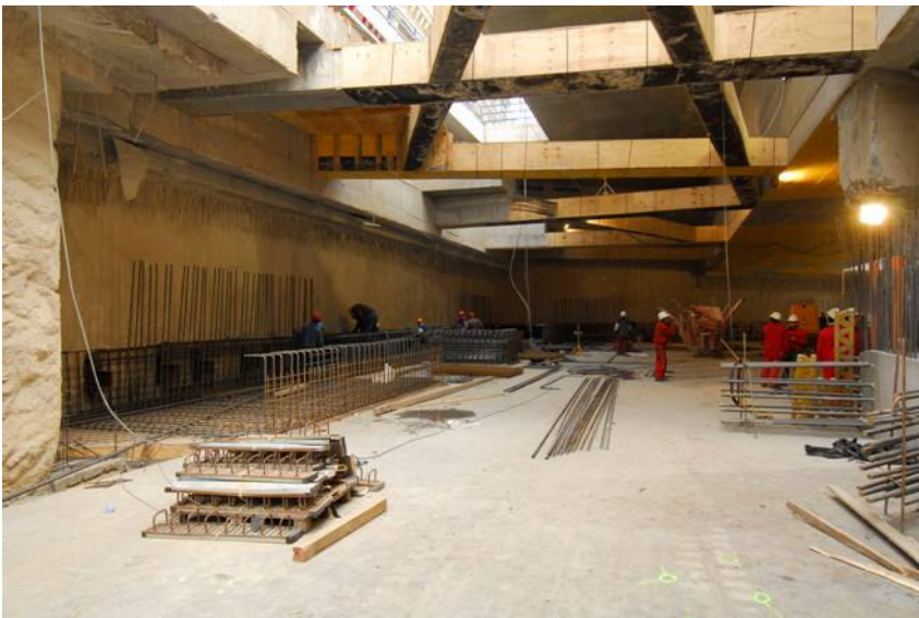
Aluljáró szinti gerendarács (ideiglenes védőburkolattal ellátva)
