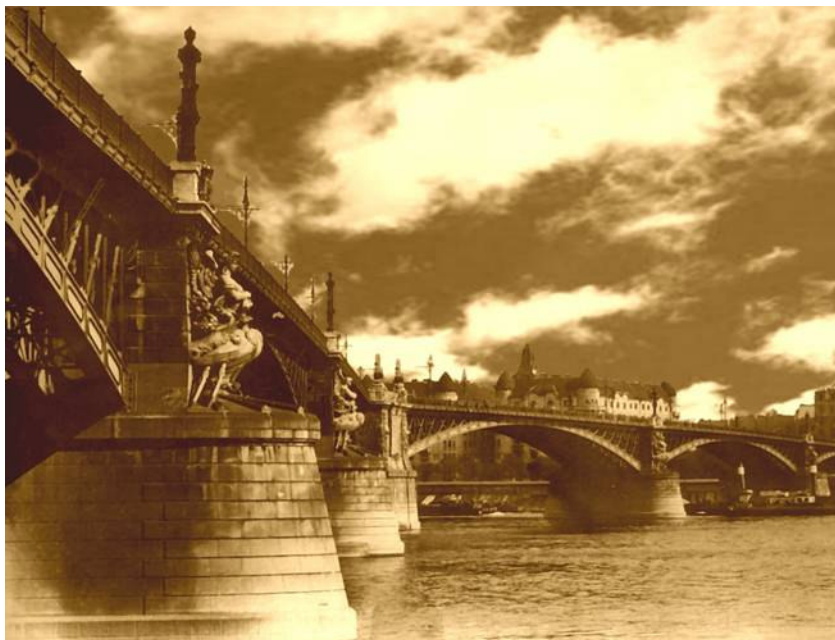
A híd eredeti déli oldali nézete
