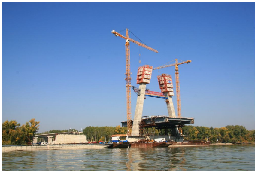
Az állványon összeszerelt hídszakasz
