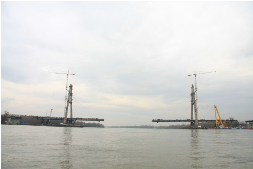
Az épülő felszerkezet
