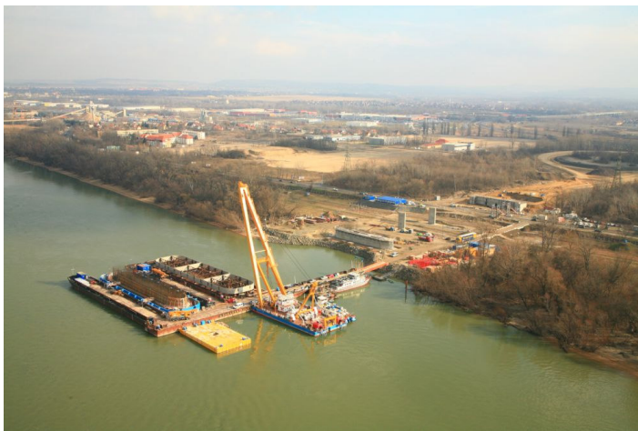
Az épülő mederpillér
