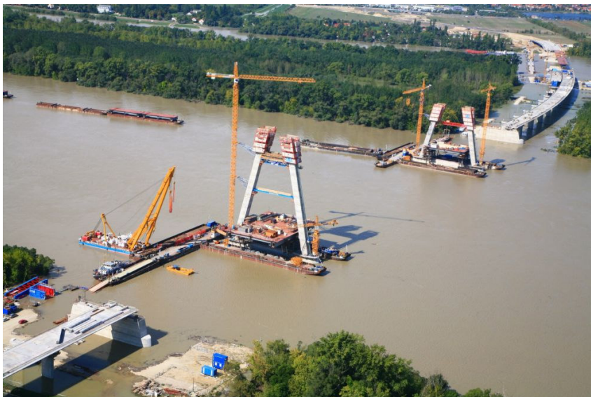
Építés közbeni állapot
