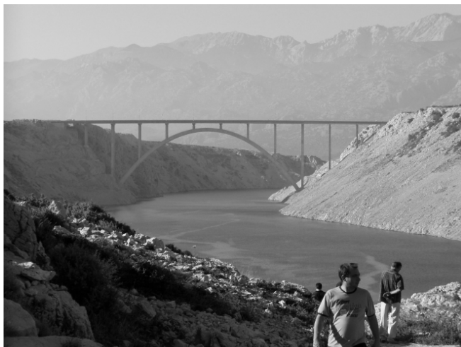
A 200 m főnyílású, vasbeton, Maslenica autópályá híd
