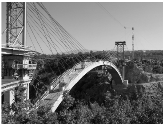
A Split-Ploče közötti szakaszon épülő, 140 m főnyílású völgyhíd
